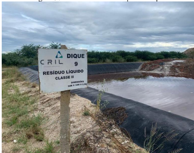
Figura 37 – Placa de identificação do dique.
