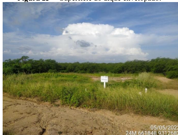
Figura 23 – Superfície do dique envelopado.
