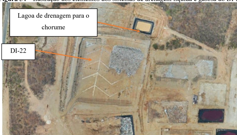
Figura 54 – Ilustração dos elementos dos sistemas de drenagem líquida e gasosa do DI-22.
