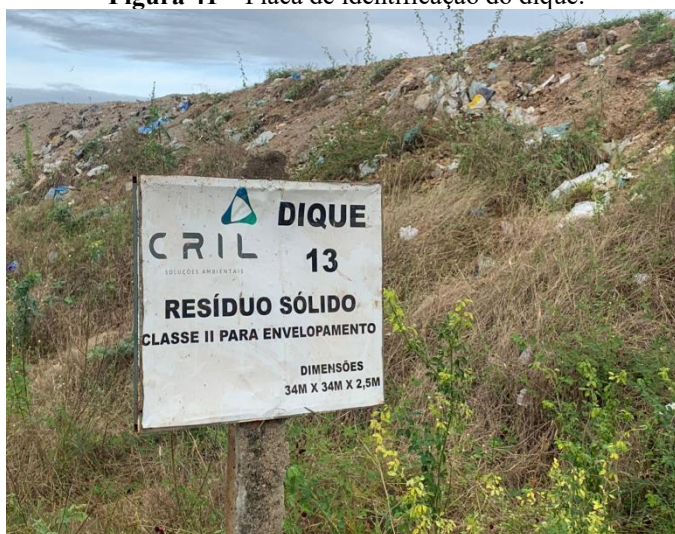
Figura 41 – Placa de identificação do dique.
