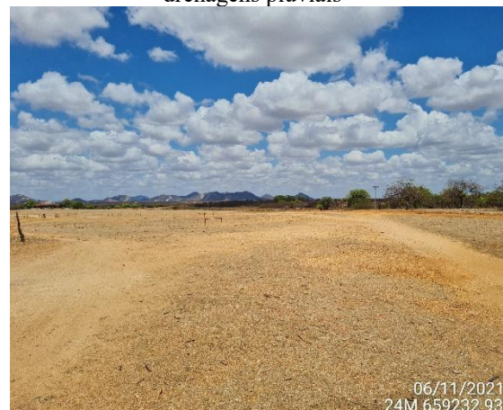
Figura 329 Ruas da zona rural sem sistema de drenagens pluviais
