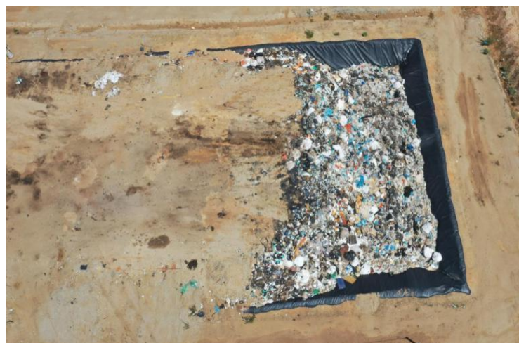
Figura 52 – Vista por cima do dique ilustrando seu estado de operação.
