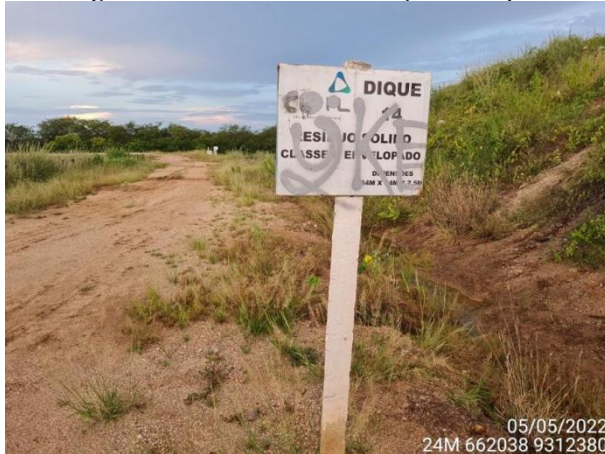
Figura 42 – Placa de identificação do dique.
