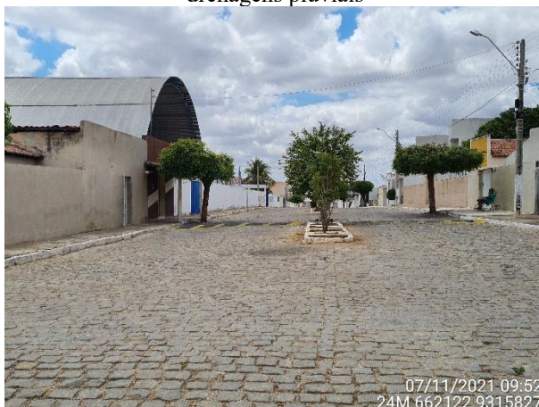
Figura 328 - Ruas do núcleo urbano sem sistema de drenagens pluviais
