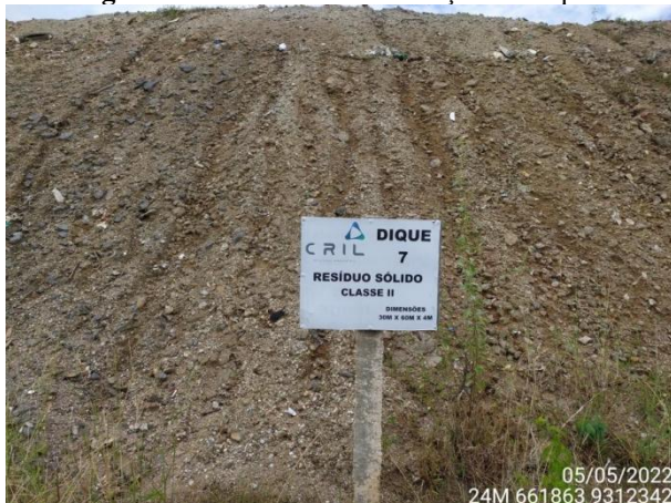
Figura 33 – Placa de identificação do dique.
