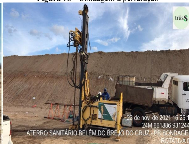
Figura 98 – Sondagem à perfuração
