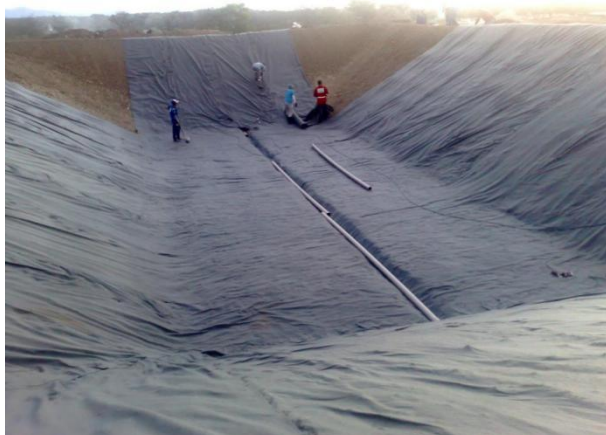
Figura 15 – Aplicação da geomembrana no dique do Aterro da Cril.
