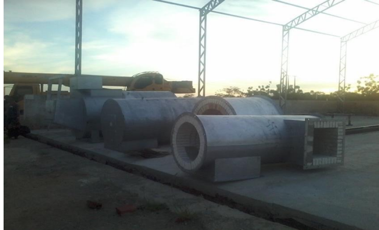
Figura 56 – Vista das câmaras cilíndricas com chapas de aço revestidas internamente com tijolos refratários durante a montagem.
