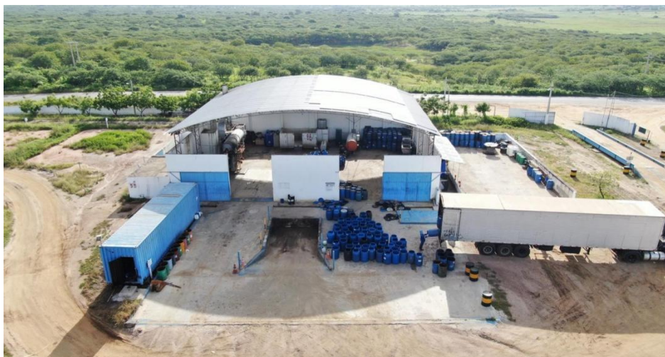
Figura 7 – Galpão ilustrando o incinerador, chaminé, autoclave e áreas de apoio e descarregamento.
