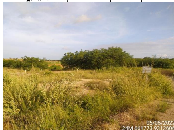
Figura 29 – Superfície do dique envelopado.
