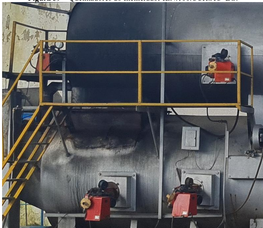
Figura 59 – Queimadores do Incinerador IEN.100.CCH.AC-LG.
