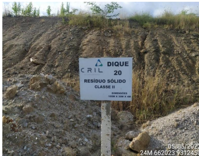
Figura 51 – Placa de identificação do dique e superfície elevada com o compartimento superior do dique.
