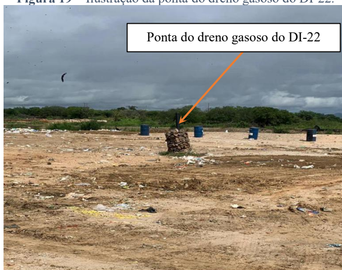
Figura 19 – Ilustração da ponta do dreno gasoso do DI-22.
