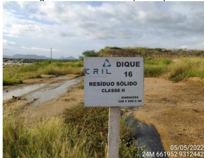
Figura 46 – Placa de identificação do dique.
