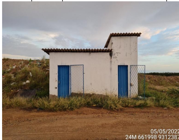
Figura 8 – Edificação em alvenaria com caixa d’água de 500 litros para dar suporte às atividades realizadas no campo.
