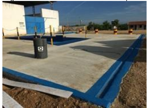
Figura 10 – Detalhe da canaleta de coleta de líquidos.
