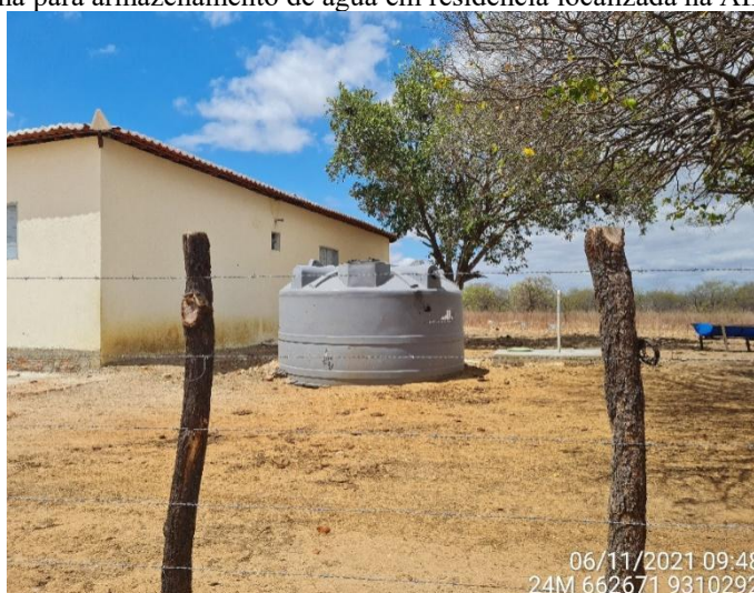
Figura 352 – Cisterna para armazenamento de água em residência localizada na AII do empreendimento.
