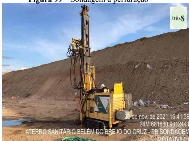
Figura 99 – Sondagem à perfuração
