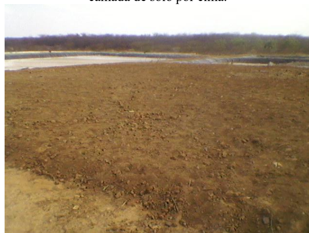
Figura 16 – Dique envelopado com geomembrana e camada de solo por cima.
