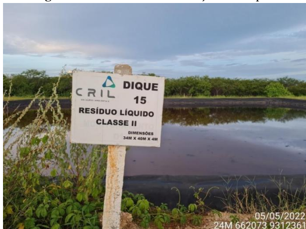
Figura 44 – Placa de identificação do Dique.
