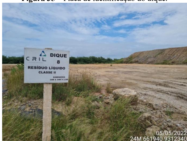
Figura 35 – Placa de identificação do dique.
