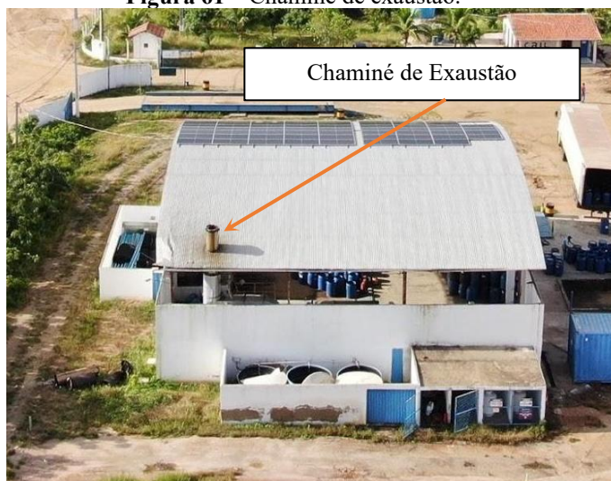
Figura 61 – Chaminé de exaustão.
