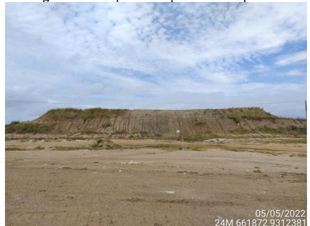
Figura 34 – Dique c/ compartimento superior.
