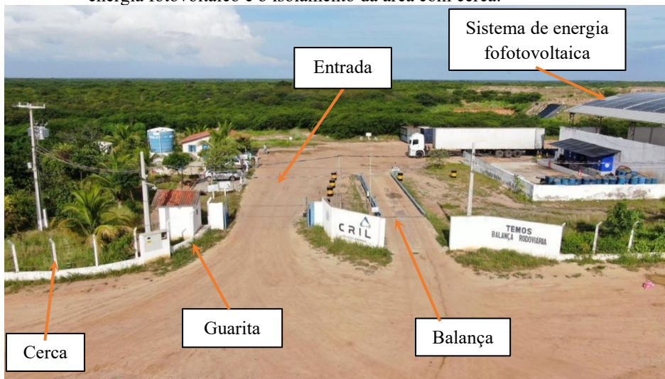
Figura 4 – Vista da entrada do empreendimento, ilustrando a guarita, a balança sistema energia fotovoltaico e o isolamento da área com cerca.
